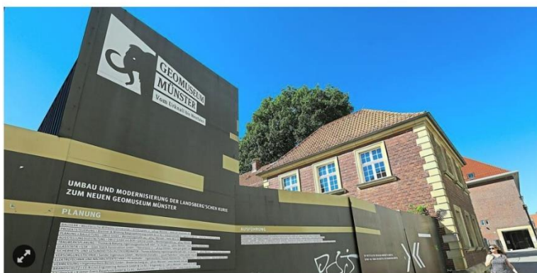
Baustelle Geomuseum an der Pferdegasse im Herzen der Stadt. Hier wird seit nahezu zehn Jahren saniert - Ende ungewiss. Foto: Oliver Werner
